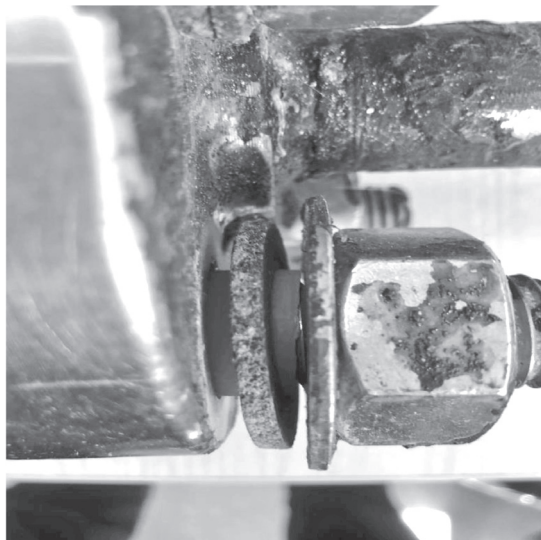
(b) 法兰垫片实物图
