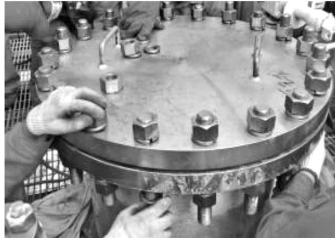
图3 安装 DN600 带孔的(盲)法兰盖
