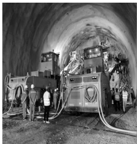
图2 某两臂凿岩台车及其参数
