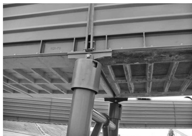
图6 单元模块和铰接座示意图
