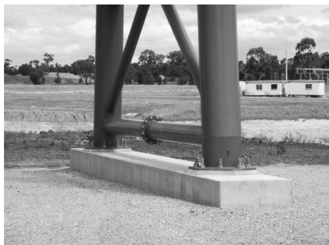
图3 地面做水泥台打地脚孔示意图
