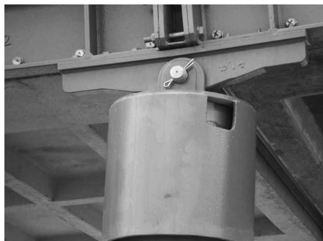
图5 圆柱形立柱和铰接座示意图
