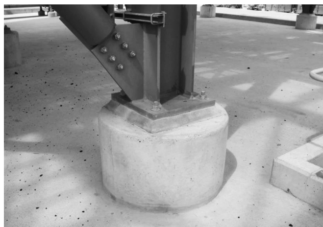
图4 圆柱形立柱示意图
