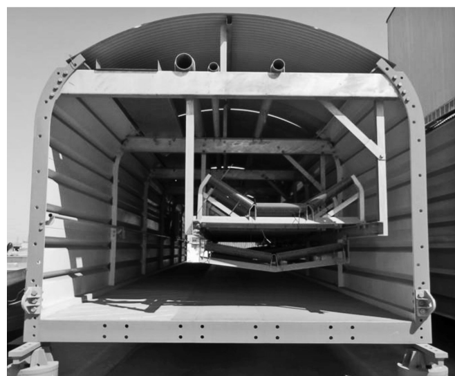
图7 销轴连接单元模块示意图
