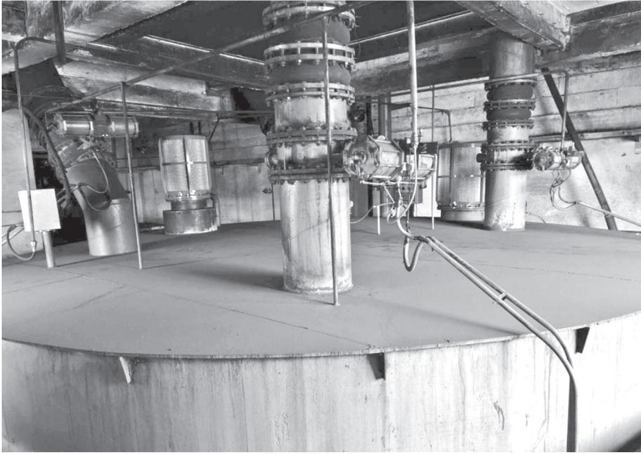
图6 5号高炉圆形无焰泄放装置安装效果图(改造后)
