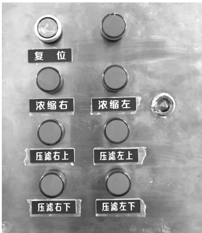
图 3 跑偏报警控制柜外观改造
