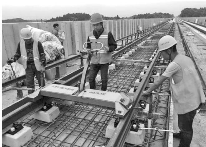
图1 手推式轨道线路智能检测装置
