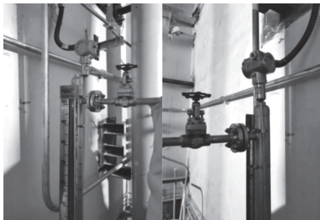
图 4 AT100BC 磁致伸缩液位计图
