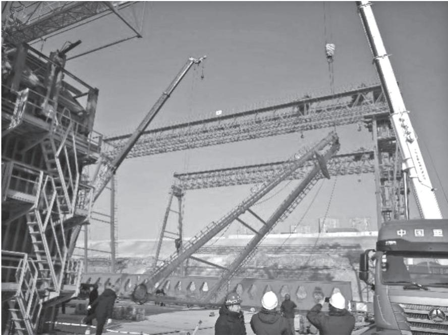
图1 铁路工程施工中双机抬吊作业
