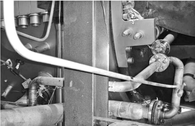
图 2 轴衬位置管路短接旁通图 坏，因此需要评估并选择适当的油冲洗方案。
