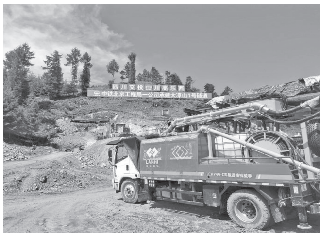
图 4 拱架安装台车
