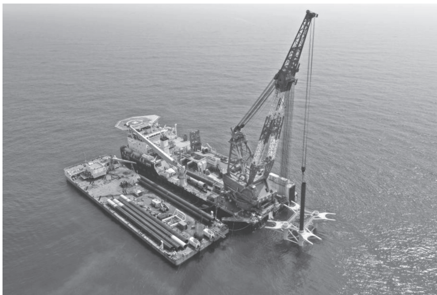
图3 海上嵌岩施工平台
