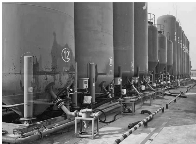
图 设备改造完成后的现场图
