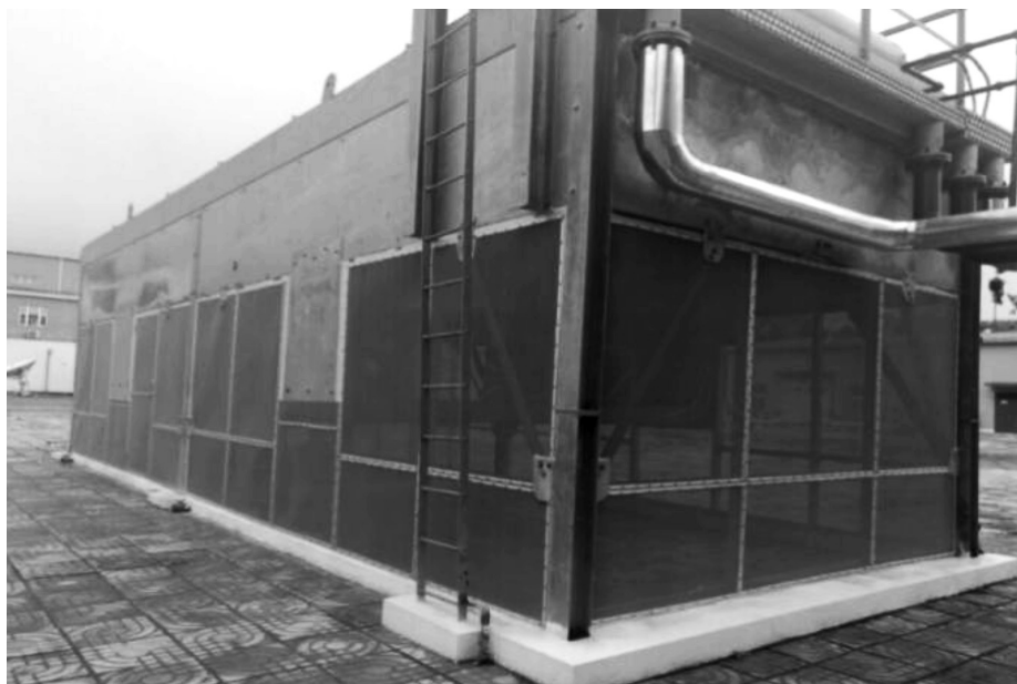
图 1 卡特彼勒 G3616 天然气发动机的冷却系统空冷器防虫网
