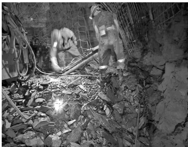
图 1 常规锚杆机支护
