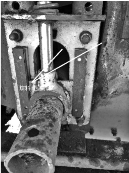
图 1 现场漏斗侧壁煤料撒漏口
