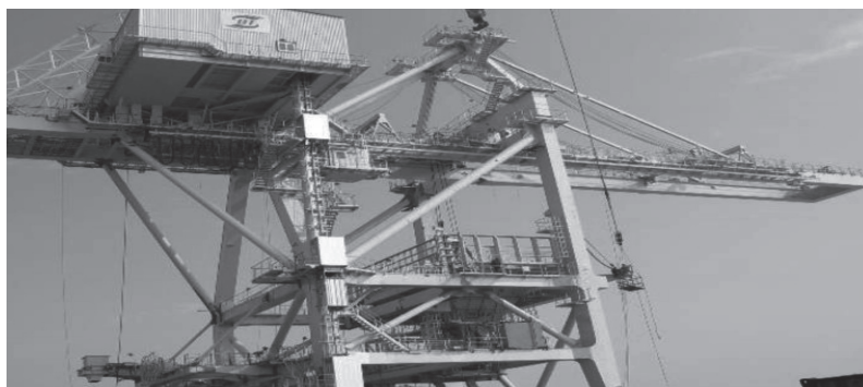
图1 桥式抓斗卸船机钢结构部分
