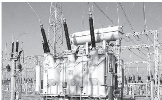
图 2 变压器安装
