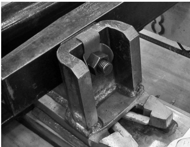
图 护轨螺栓防松
