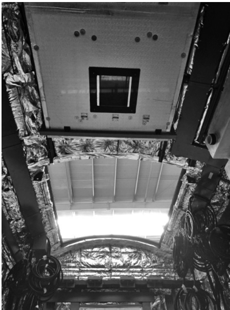
图 2 防寒材各部位安装效果
