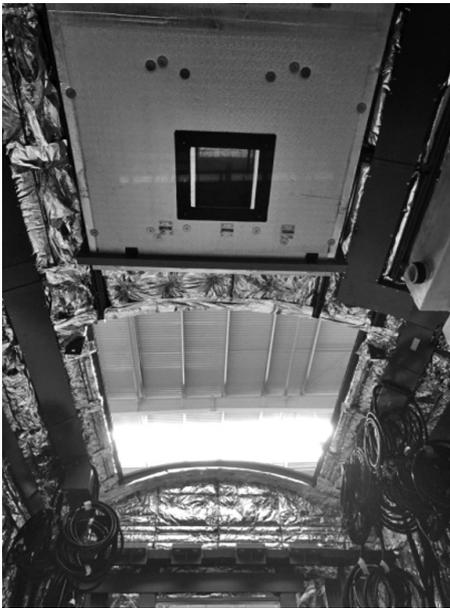
图 2 防寒材各部位安装效果
