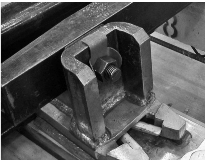
图 护轨螺栓防松
