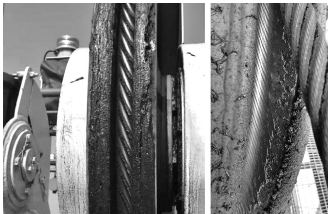
图 2、图 3 现场滑轮起槽情况
