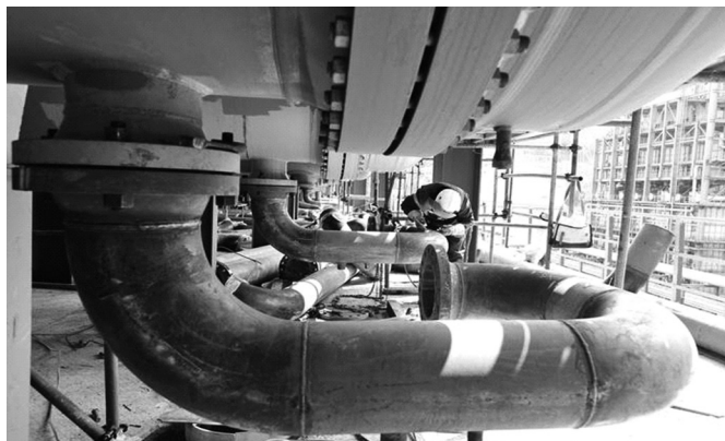
图 1 焊接工人正在进行焊接工作
