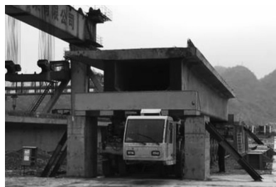
图3 运梁车顶梁图
