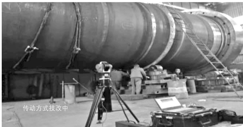
图3 技改最后阶段对齿轮进行调整安装
