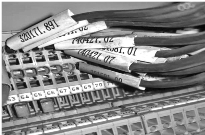
图5 低压柜内接线端子
