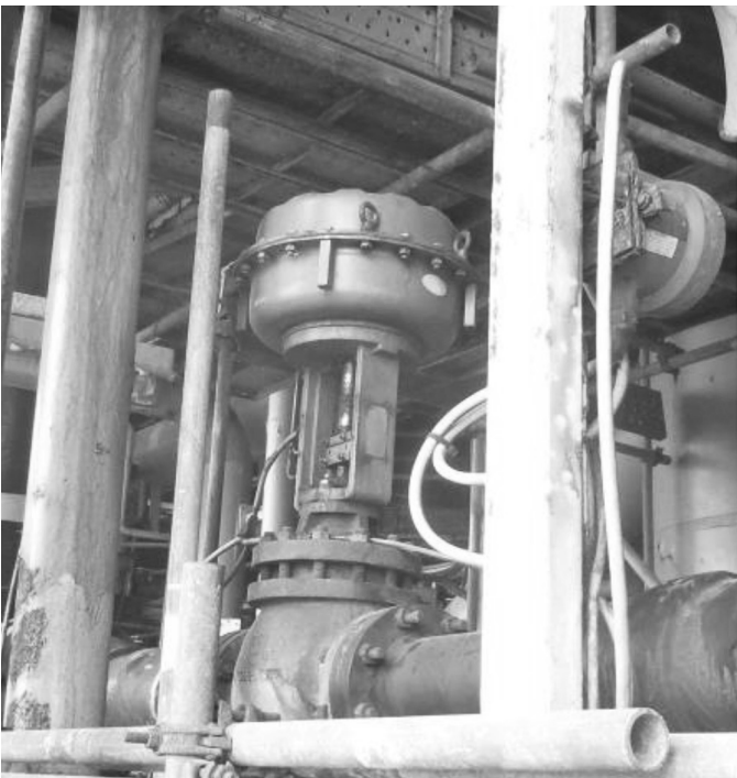
图 2 同类装置采用的气动薄膜式压力控制阀
