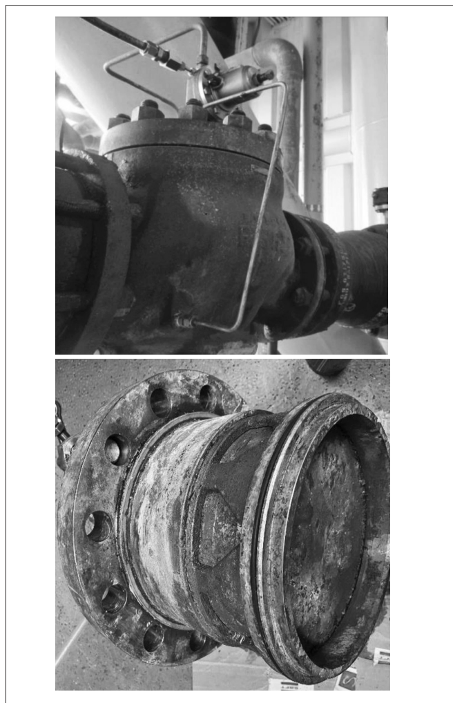
图 1 乐东 22-1 气田采用的自力式压力控制阀
