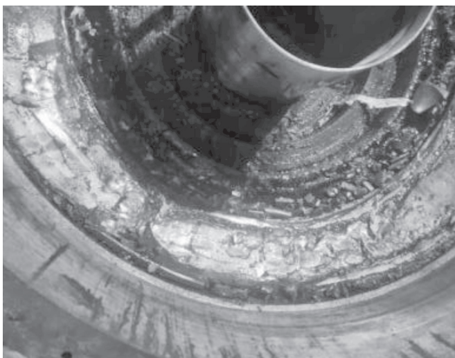
图2 滚道磨损剥落
