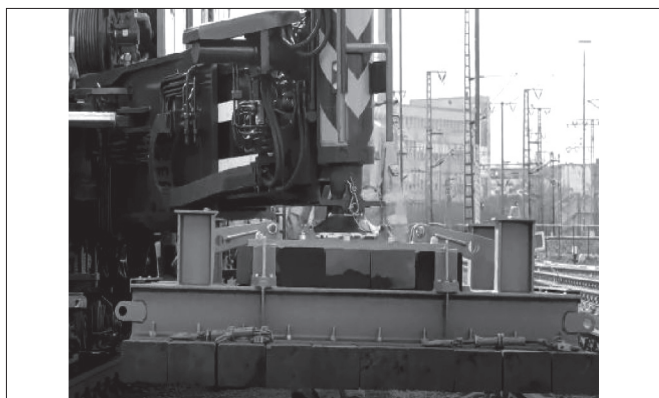
图1 附挂组合枕垫自力走行的德国联邦铁路公司起重机
