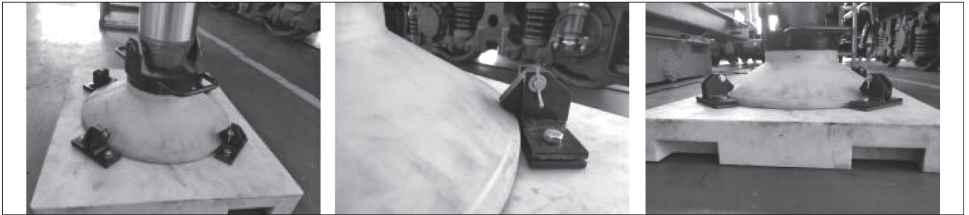
图 4 快速连挂支腿垫块支承状态
