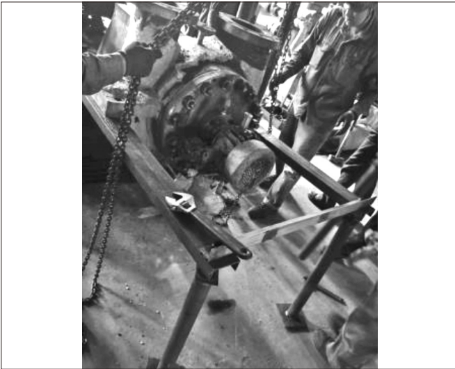
图 3 专用工具整体安装情况
