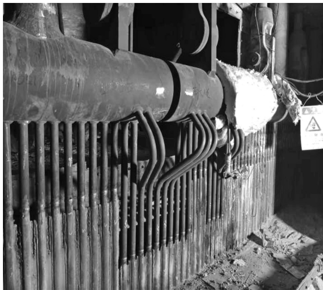
图1 锅炉侧水冷壁上集箱分段后实物图
