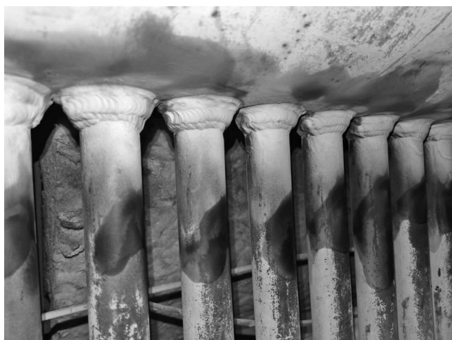
图2 锅炉侧水冷壁上集箱接管座补焊加强后实物图
