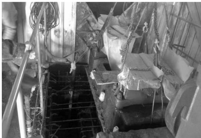
图 3 引风机基础浇筑采用一次成型工艺现场施工图
