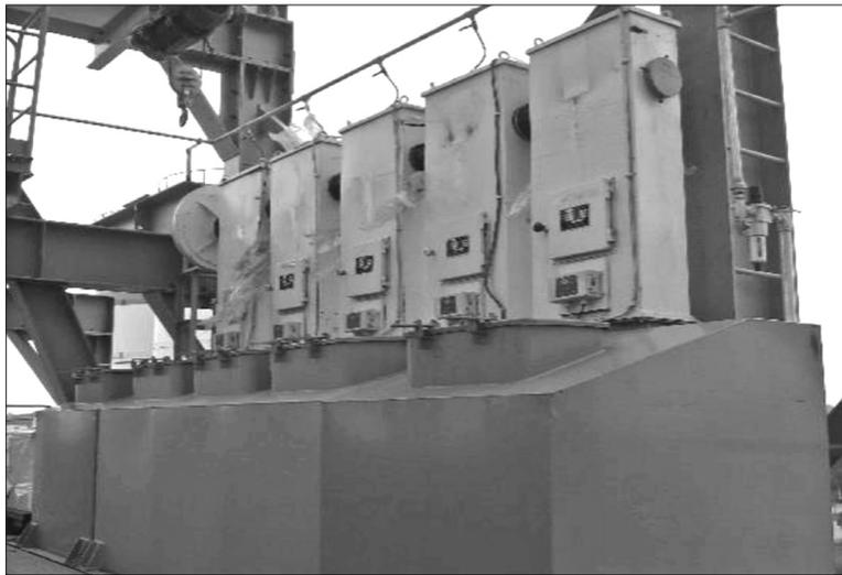
图3 多个添加剂仓共用单个除尘器管道引风机实物图(方案二)
