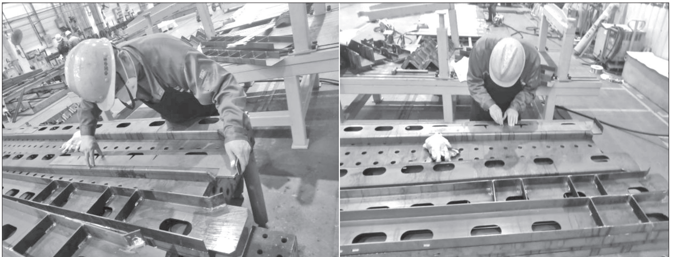
图 4 底架横梁吊座模块组装画线
