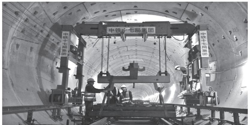
图1 轮轨式地铁铺轨机组
