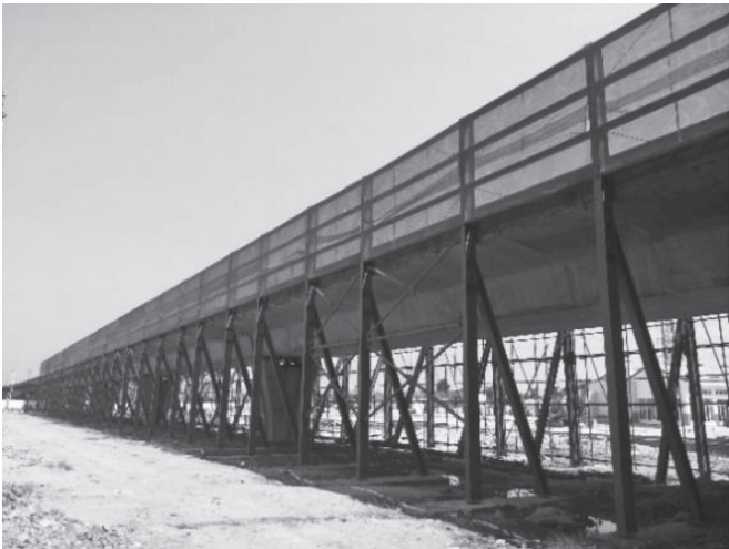
图 10 第一阶段防护安装效果图
